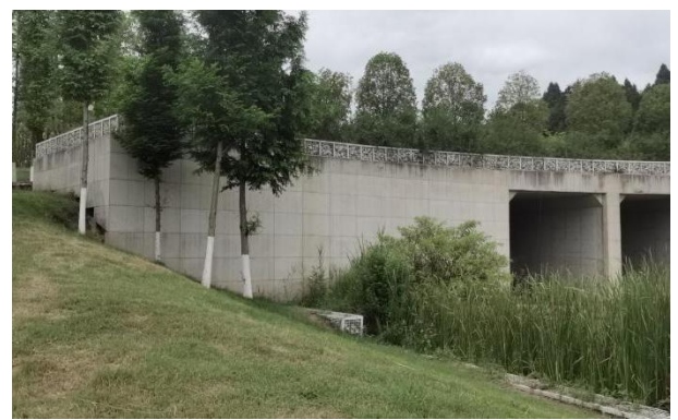
项目南侧现状（排洪渠旁）
