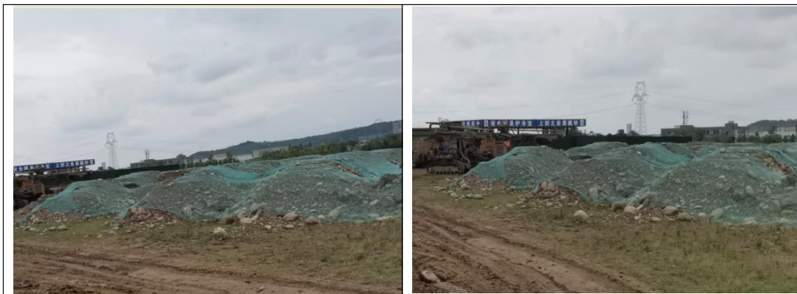
图 3.2-5 临时堆土场密目网遮盖
