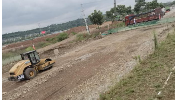
绵盛路下穿隧道土石方回填现状
