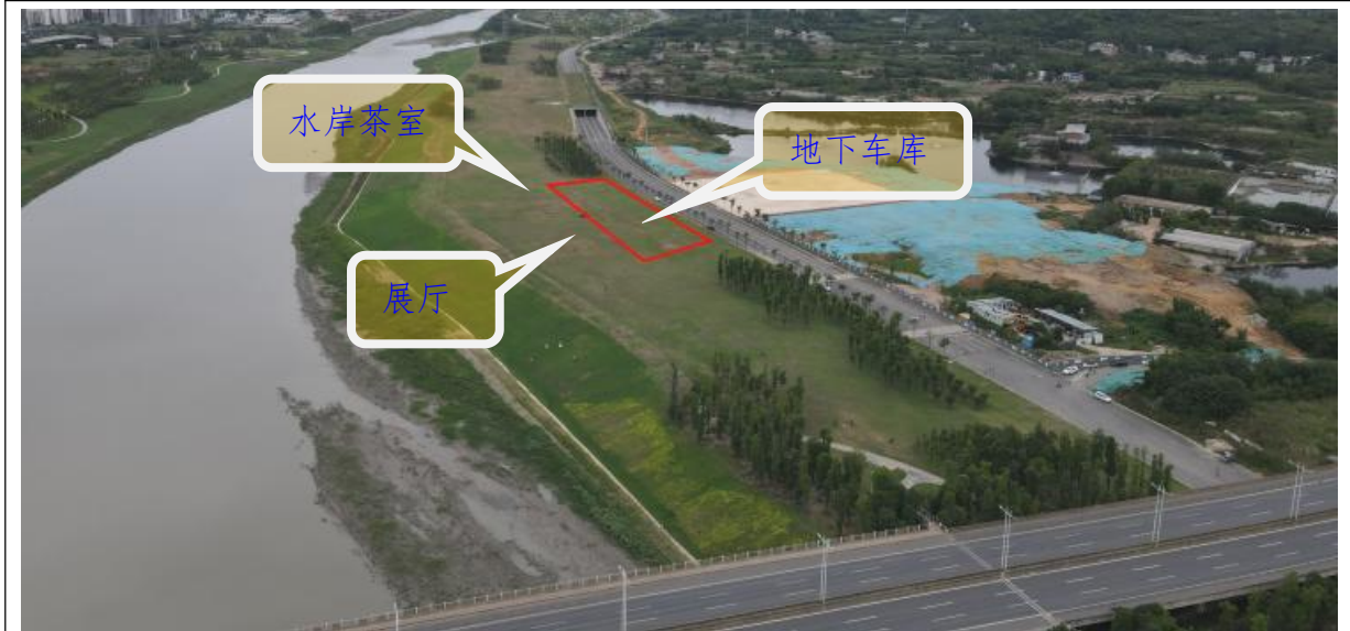
6#地下车库、1#展厅、2#水岸茶室原状
