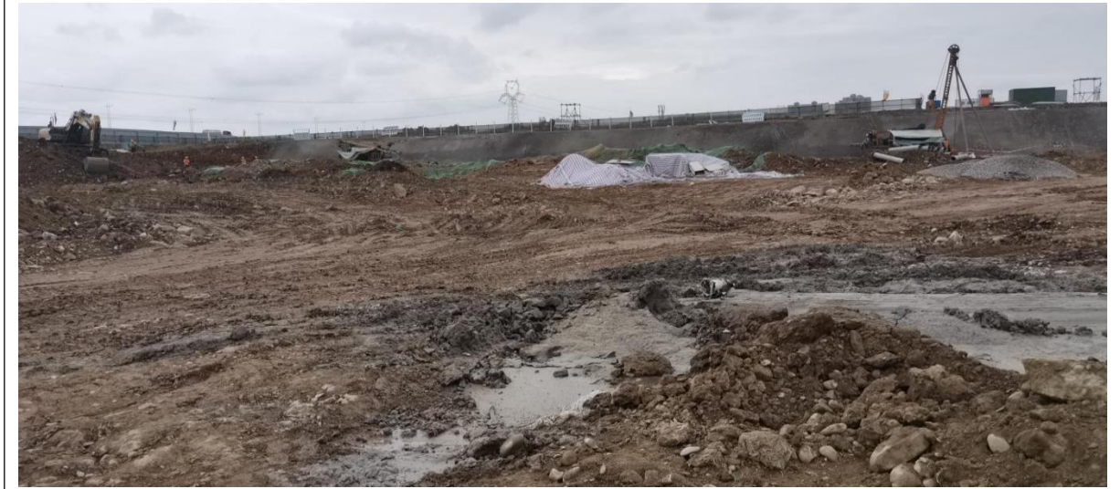
6#地下车库现状（在建，前方 1#展厅、右侧 2#水岸茶室）
